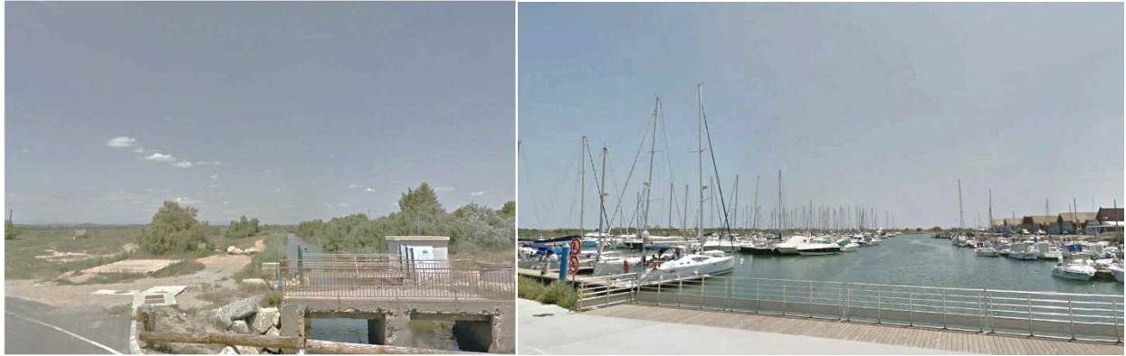
Passage de la vanne, perception en direction du nord et du sud
